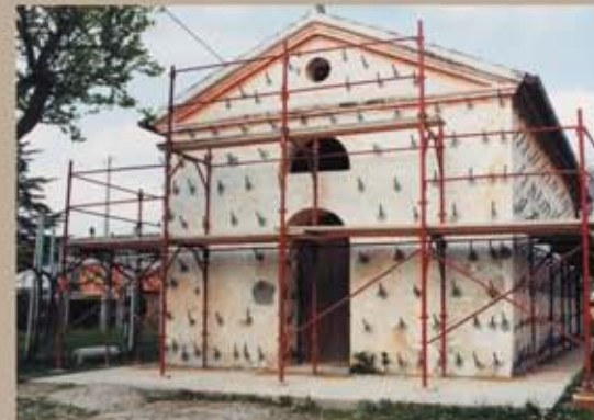
Operazioni di consolidamento - iniezioni
