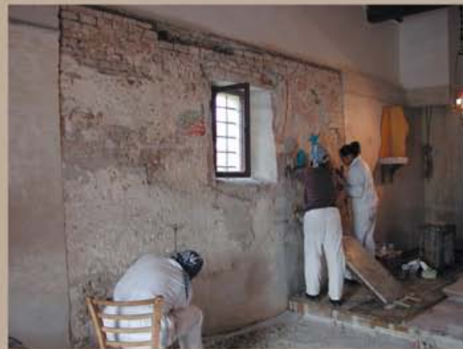
Parete nord durante i restauri
