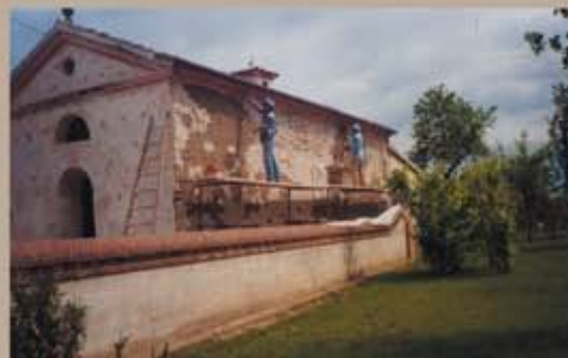
Rifacimento intonaco - prospetto sud
